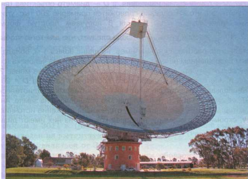
Рис. 126. Радиотелескоп с параболической антенной диаметром 64 м (Паркс, Австралия)
